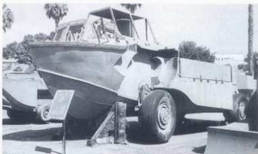
En bas à gauche. Le LVH-X2, autre engin expérimental, apparaît similaire en design au LVW-X1, mais il s'agit en fait d'un véhicule à hydrofoils pouvant atteindre la vitesse de 60 km/h sur eau.
